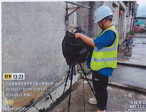
玉丰村（下架山泵站）
