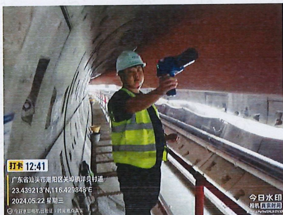
TBM 隧道洞口开端 350 米处
