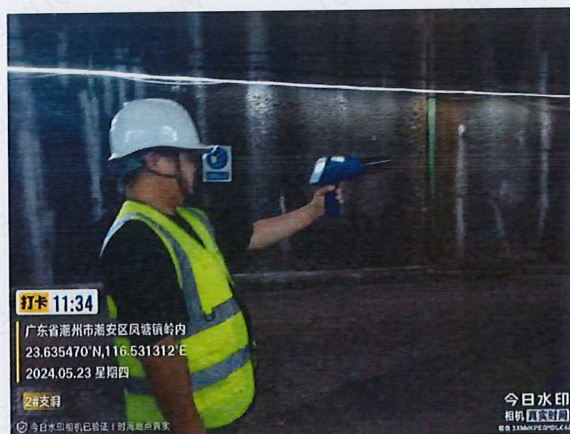
主干线隧洞段 2#支洞 50 米处
