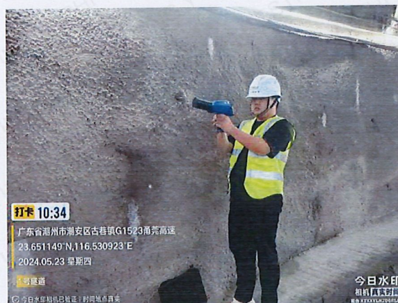
主干线隧洞段 1#支洞 50 米处
