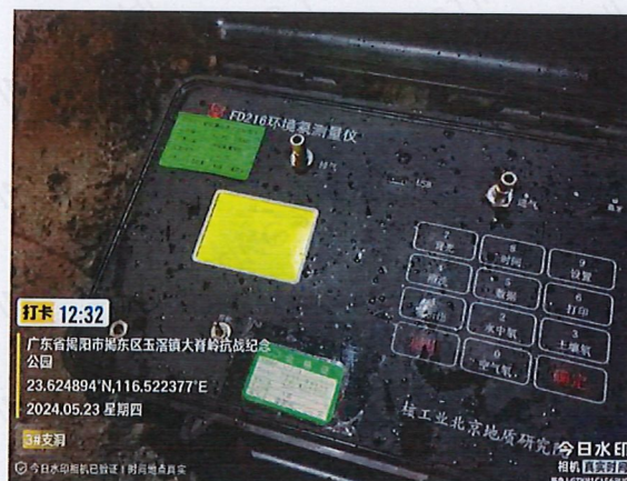
主干线隧洞段 3#支洞 400 米处
