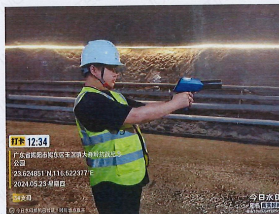
主干线隧洞段 3#支洞 450 米处
